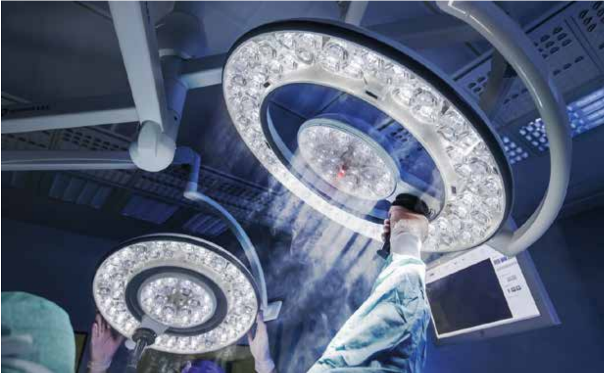
On tärkeää huomata, että vaikka ilmavirtausta voidaan hallita, se voi myös häiriintyä. Lamppujen valopäiden tai valaisinjärjestelmien muoto voi vaikuttaa ilmavirtaukseen. Sairaalat voivat investoida valtavasti rahaa ilmanvaihtoon, mutta rahat menevät hukkaan, jos ilmanvaihto ei ole yhteensopiva valaistuksen kanssa.
